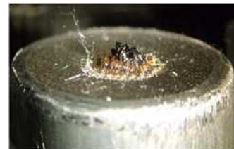
Ryc. 3: Wkładka niesprawna Światłowody stopione i zdeformowane. Wkładka nie nadaje się do dalszej eksploatacji. Konieczna wymiana
